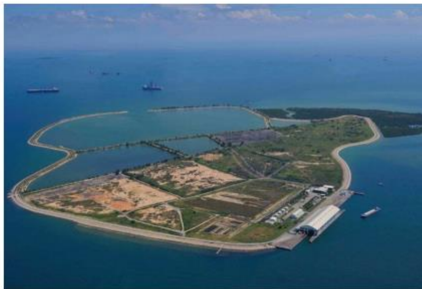
Остров – полигон г. Сингапур
