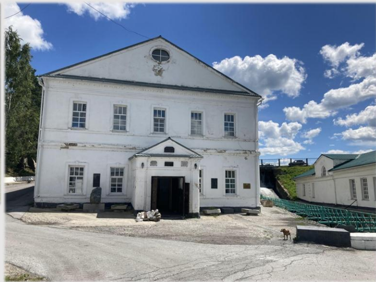
Колыванская шлифовальная фабрика (главный корпус, построен в 1802 г.)
